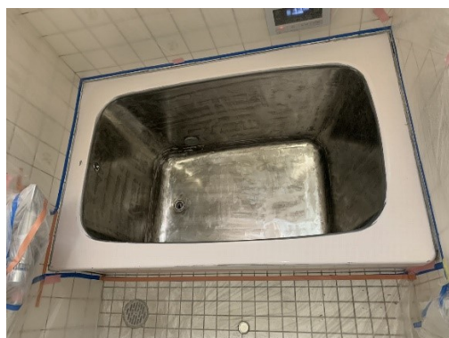
塗膜の研磨作業は終了です。
