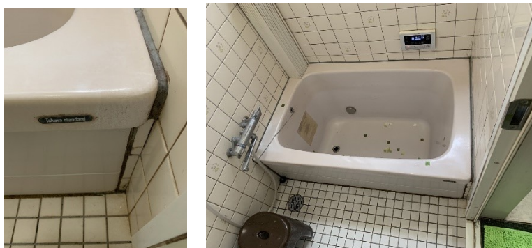
多数の剥離の有るカラスステンレスバス
