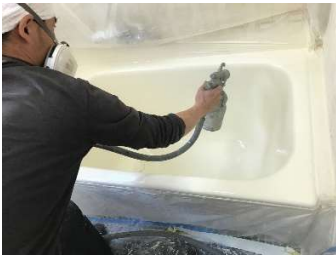
パイロキープのカップガンでの吹付け塗装景です。
