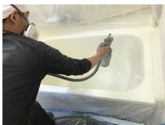
カップガンでの吹付け塗装景です。
