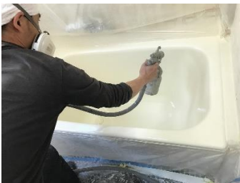
カップガンでの吹付け塗装景です。
