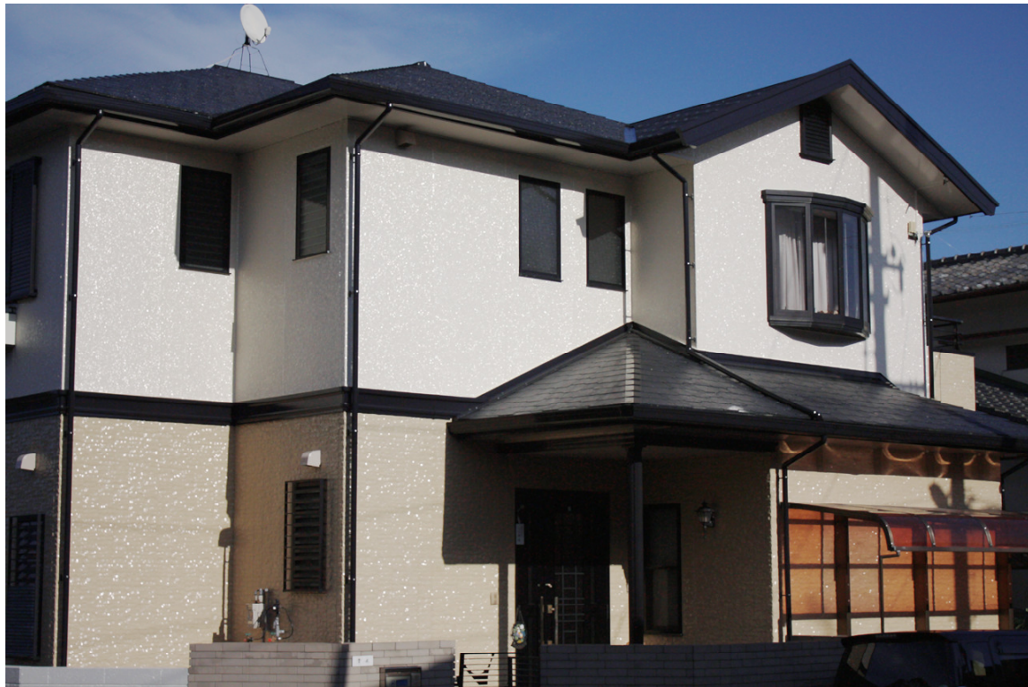
清永邸（岩国市）H22／1 堤防水塗装工業施工 フォック□185仕様
