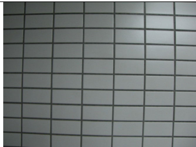
吹き付け塗装部
