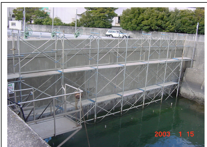
耐震及びコンクリート紡食
