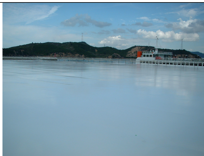
同左（大規模鋼板屋根）
