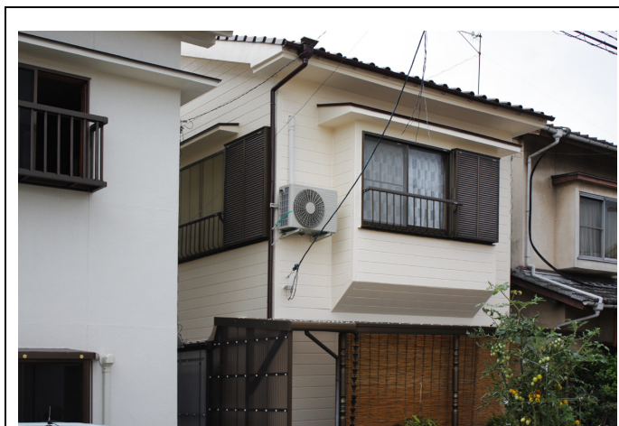
パイロキープTS2000 改修景
