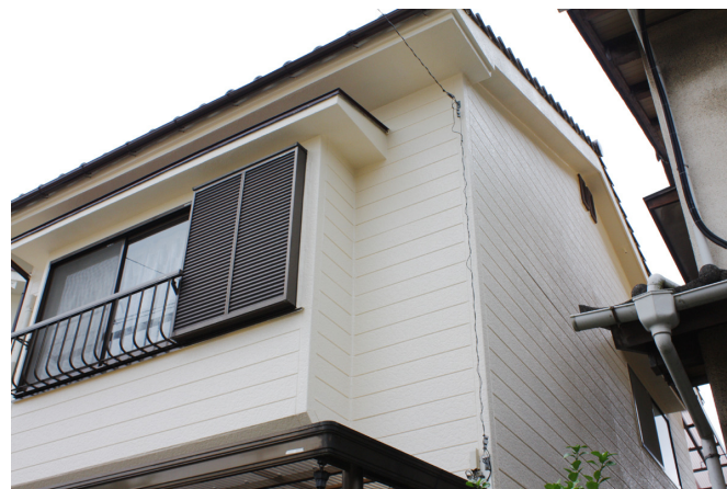
パイロキープTS2000 改修景
