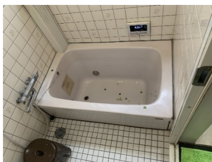
多数の剥離の有るカラーステンレスバス
