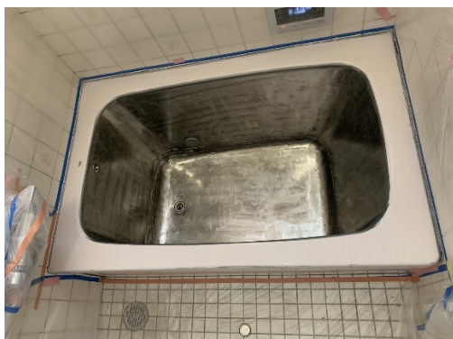
塗膜の研磨作業は終了です。
